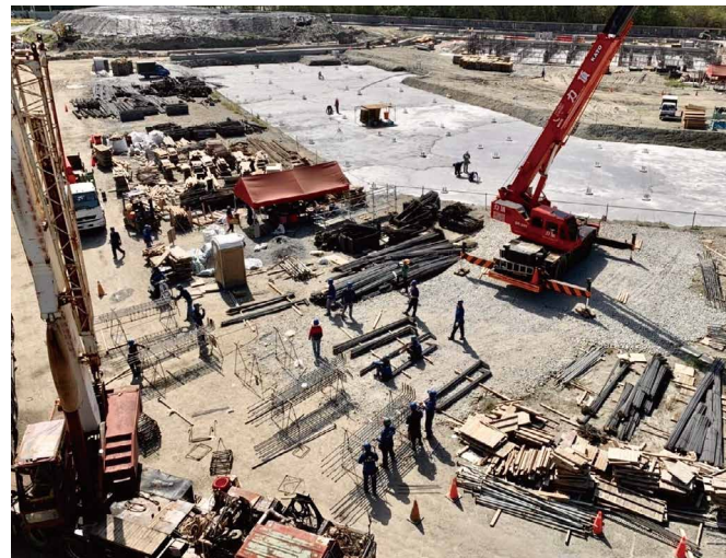
會員度假中心-基礎鋼筋綁紮
