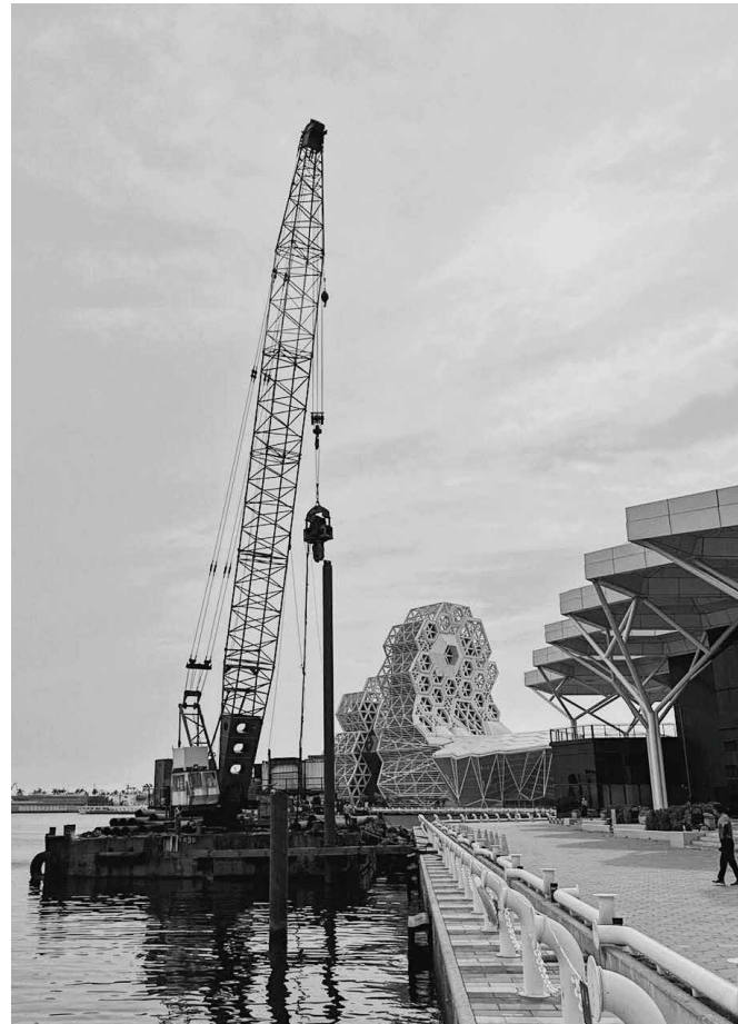
愛河灣-管樁打設工程
